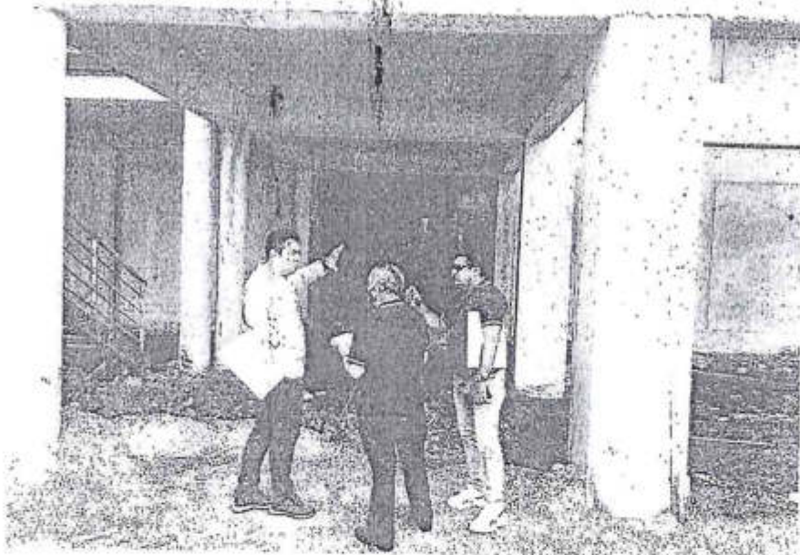
IMAGEN 2: Vista panorámica del frontis del módulo I
